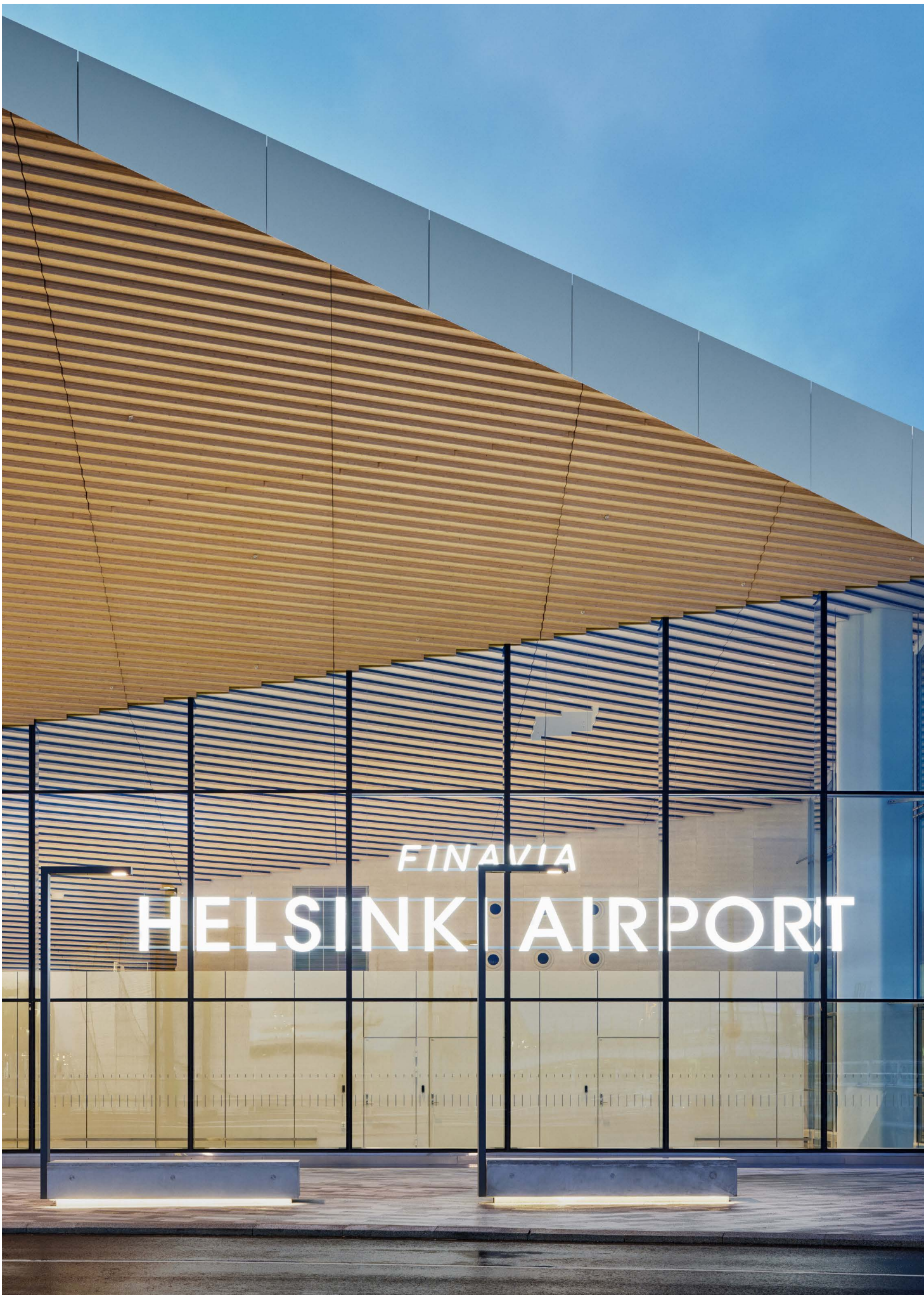
AÉROPORT D'HELSINKI Helsinki, Finlande, 2021
